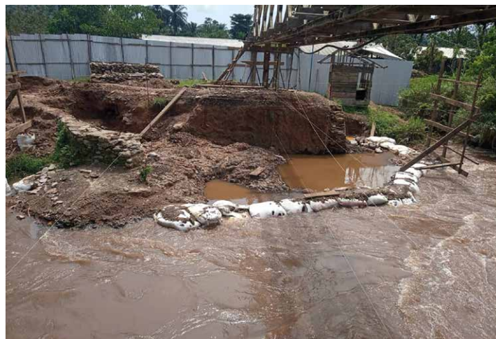
12 Hochwasser während des Baus der Pont Neuf © HEKS
