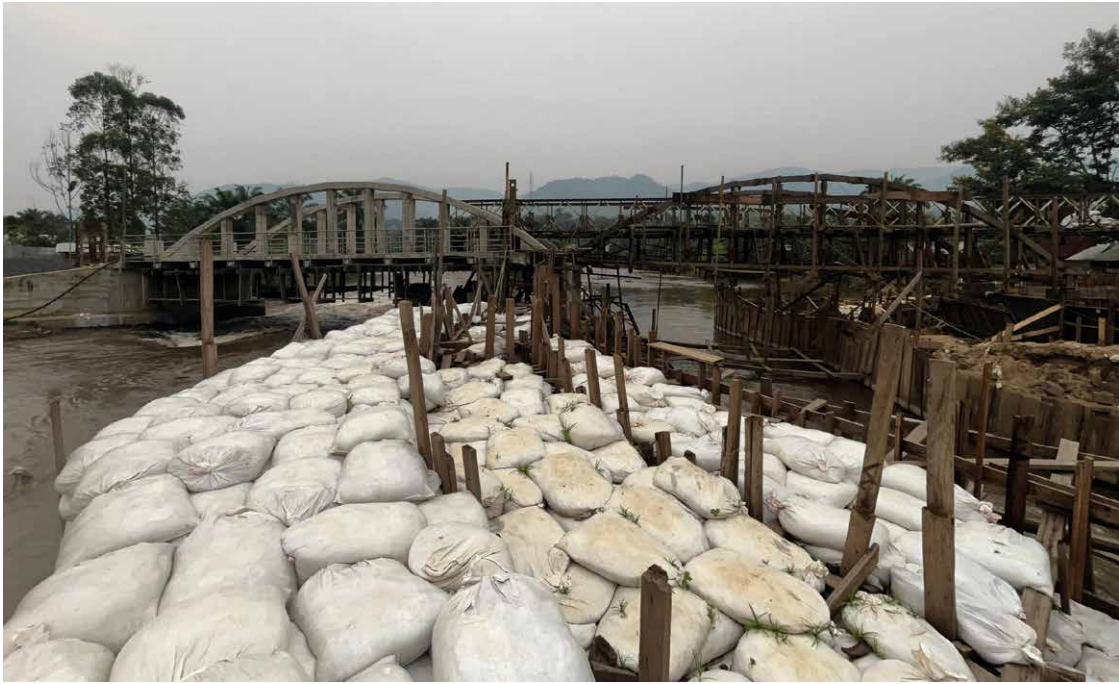
14 Pont Neuf im Bau aus Blickrichtung des äußersten temporären Damms © Bernard Tissot
