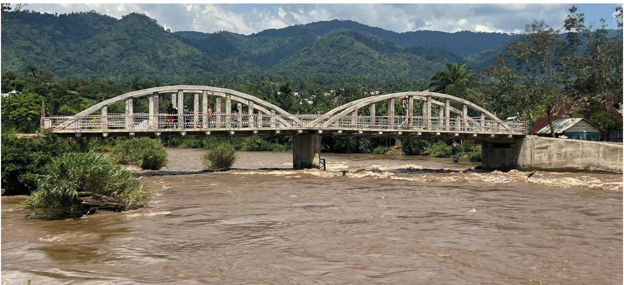
15 Erscheinungsbild der Brücke vor den Abschlussarbeiten © Bernard Tissot
