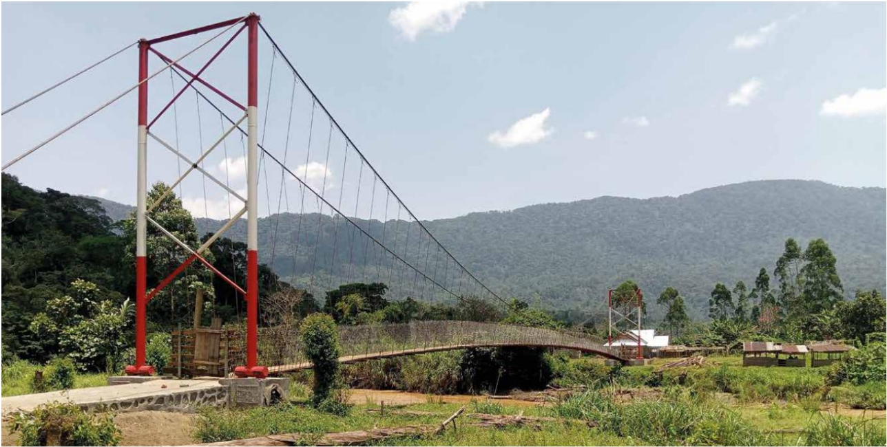
20 Nouvelle passerelle piétonne de Lukweti avant son ouverture © Gaspard
