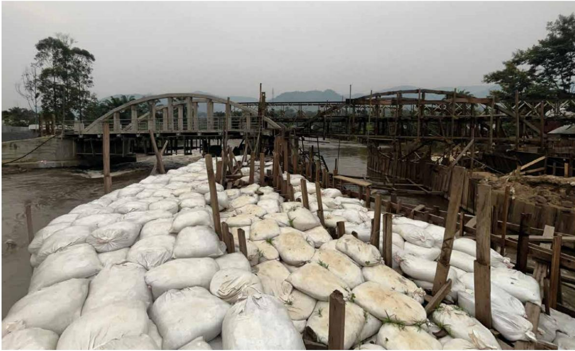
14 Pont Neuf en construction, vu depuis le barrage temporaire le plus extérieur © Bernard Tissot
