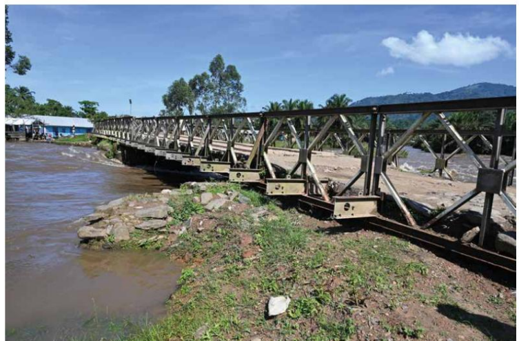
2. Pont Bailey sur la rivière Mweso en période de hautes eaux : vue depuis le sud-est © Andreas Galmarini
