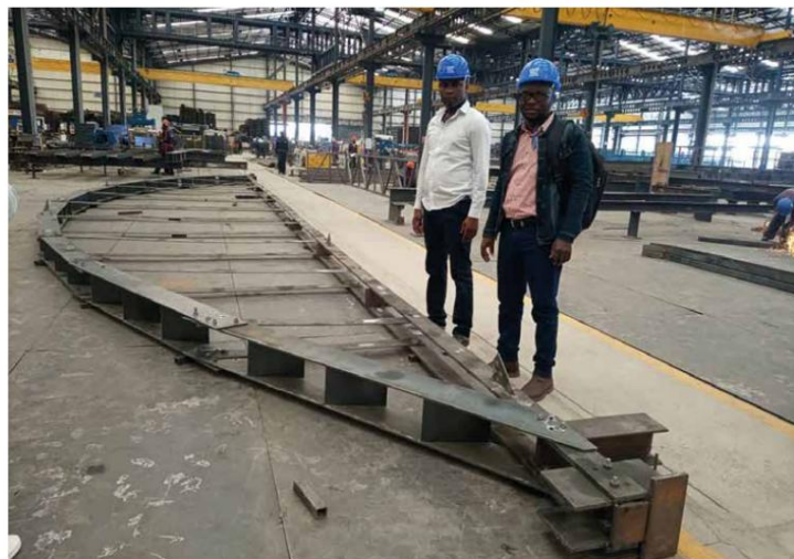
13 Pré-assemblage des arceaux en tôle d'acier en atelier © Dady Kasereka
