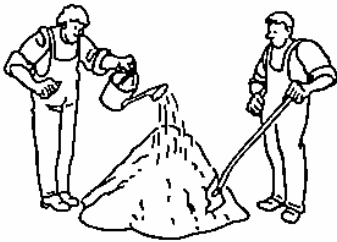
Humidifier le mélange avec un arrosoir.
