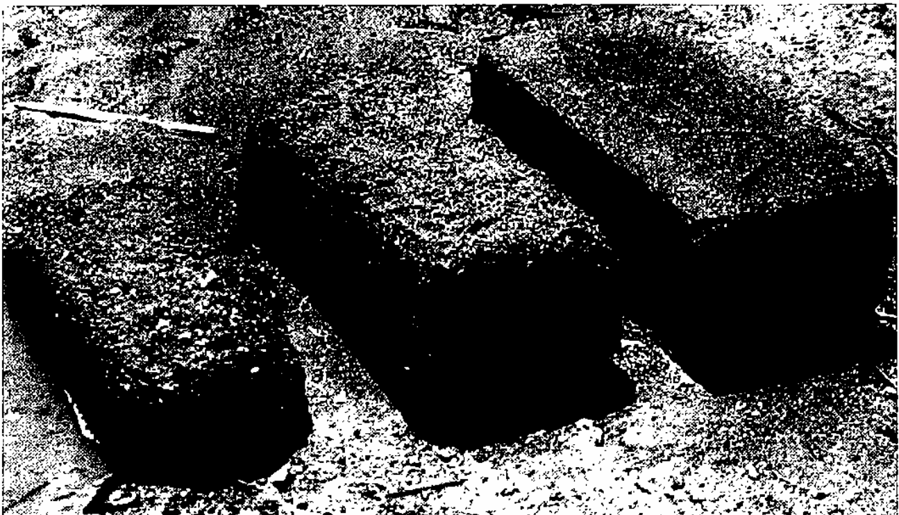
Erosion des blocs non stabilisés
