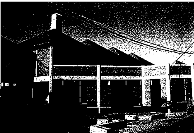
Fig. 23 : Lycée de la région Sud. Archit. L.A. Cheyssial.
