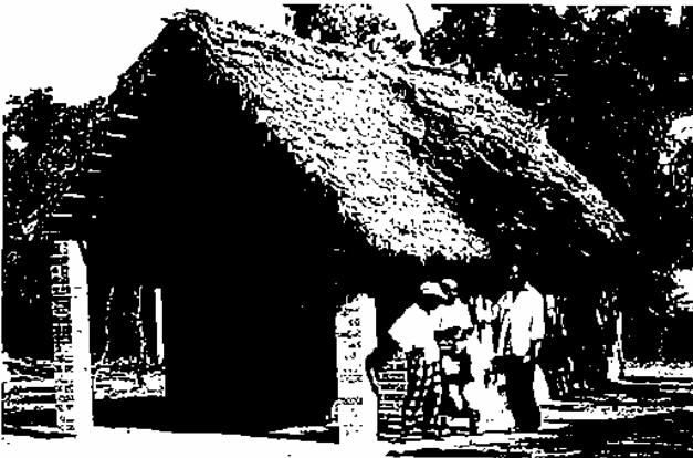
Fig. 132 : Toiture inclinée en chaume à Jos, Nigéria.
