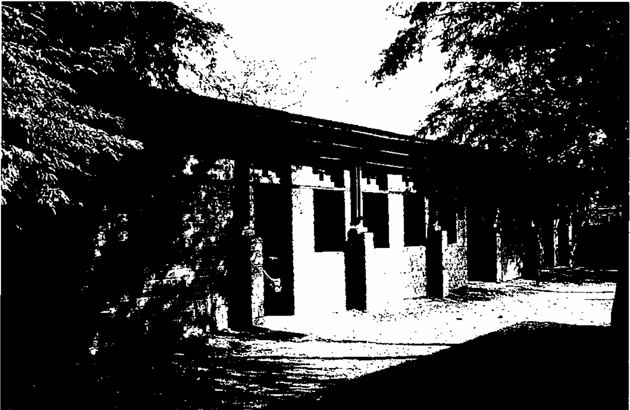
Fig. 282 : Vue de la façade du grand bâtiment des ateliers (deuxième tranche de travaux).
