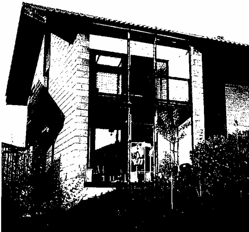
Fig. 11 : Logements en blocs de terre vibro-compactée. Archil. F. Galard.
