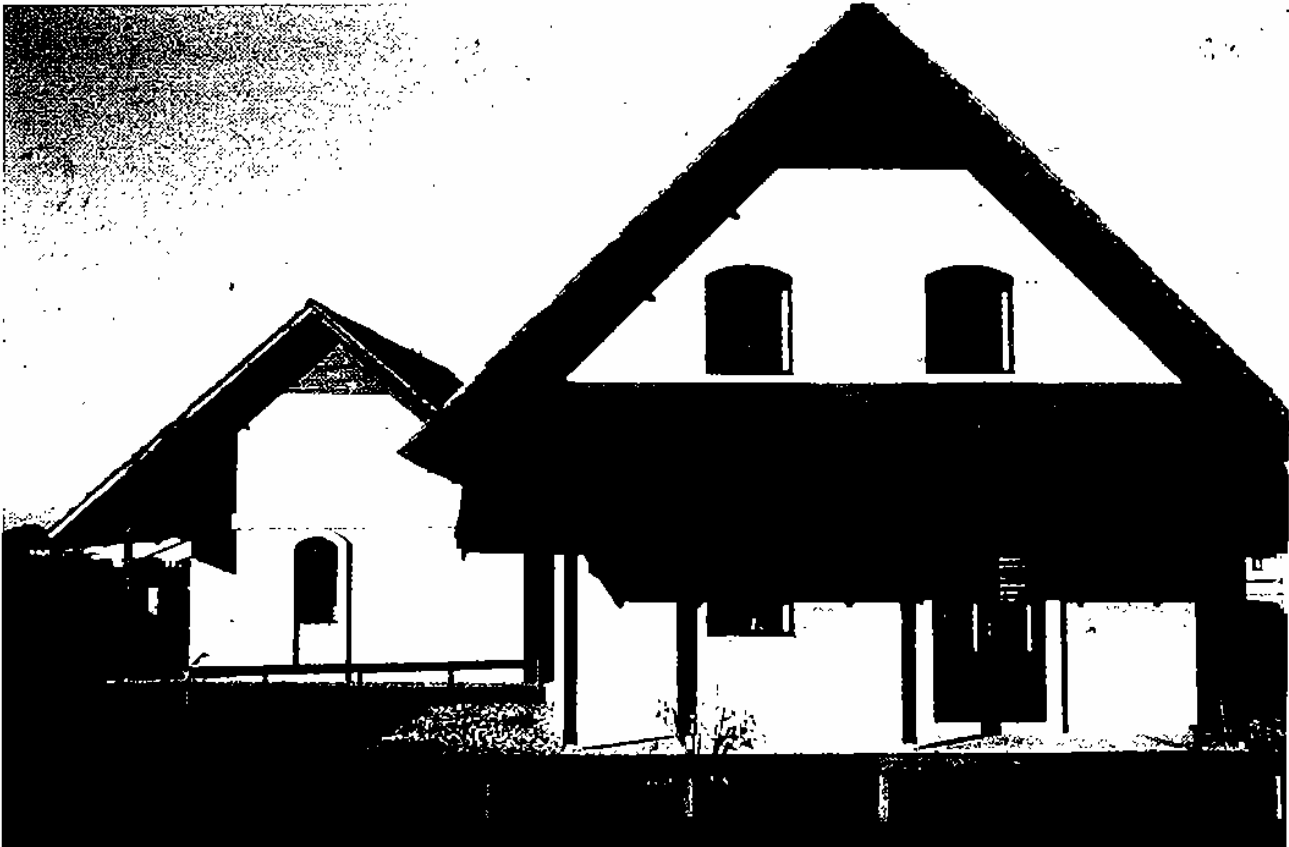
Fig. 255 : Vue générale des deux logements pilotes réalisés à Kourou. Au premier plan, pignon du logement à étage, au deuxième plan, pignon du logement de plain-pied.
