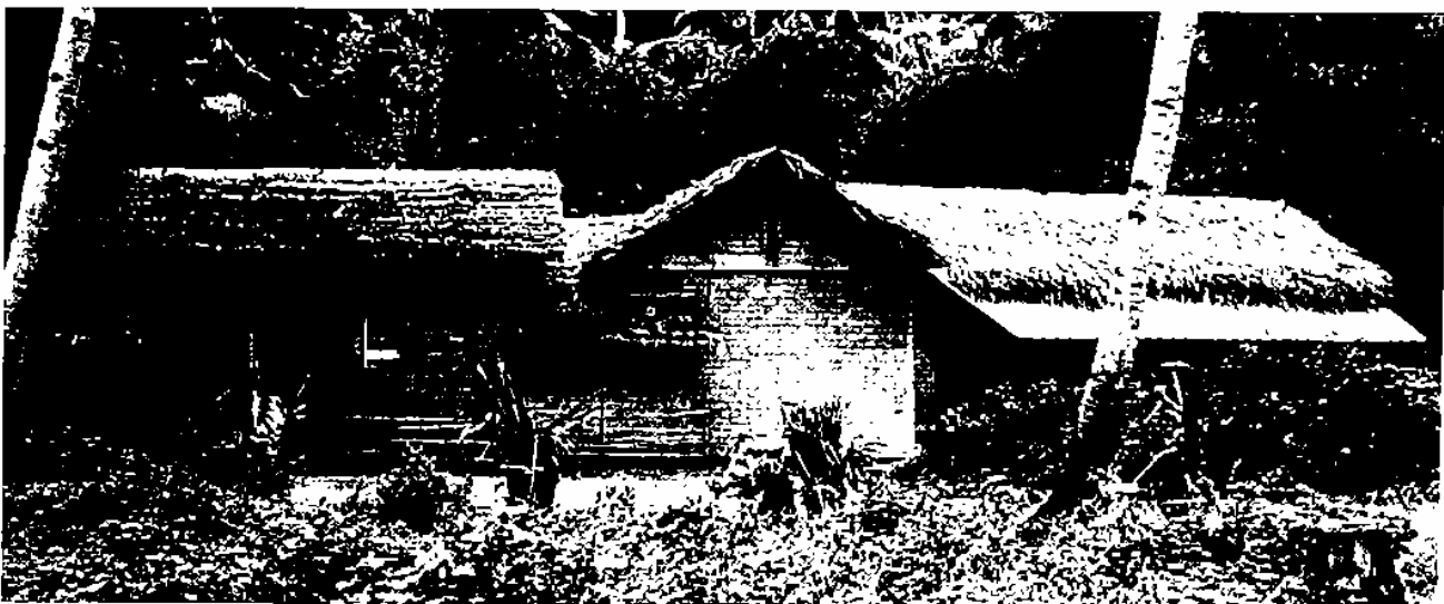
Fig. 216 : Vue générale d'un des plus grands logements de Passamaïnti, avec la sur-toiture végétale en "huanza" (feuilles de cocotier).
