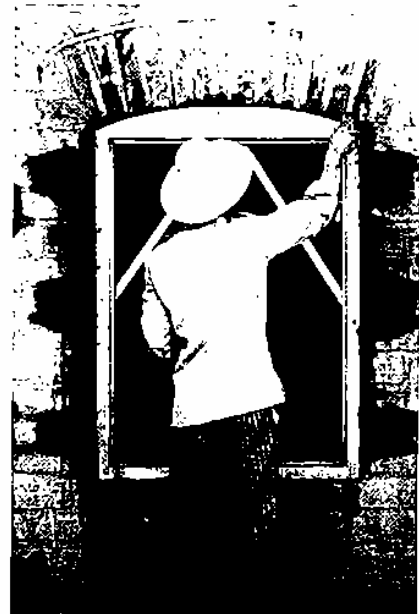
Fig. 239 : Pose des menuiseries.
