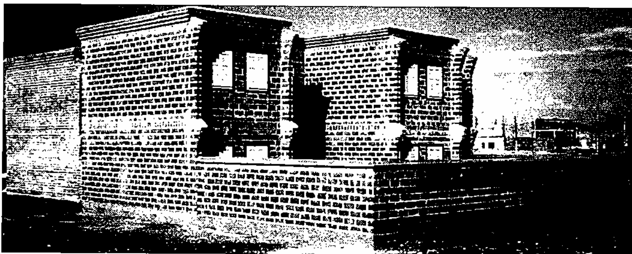
Fig. 231 : Vue générale extérieure du logement réalisé en blocs de terre vibro-compactée.
