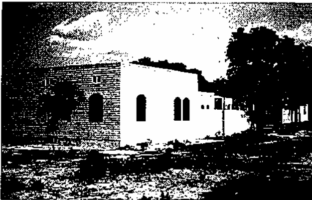
Fig. 139 : Village S.O.S. de Sanankoroba, Mali, vue générale.
