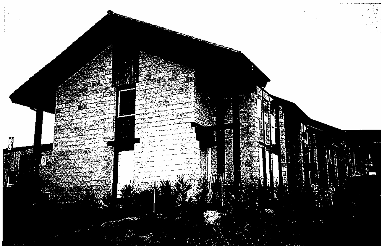
Fig. 14 : Vue détaillée d'un ensemble d'habitat en blocs de terre vibro-compactée au "Domaine de la Terre".
