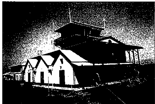
Fig. 24 : Aéroport de Mayotte. Archit. P. Rollet.
