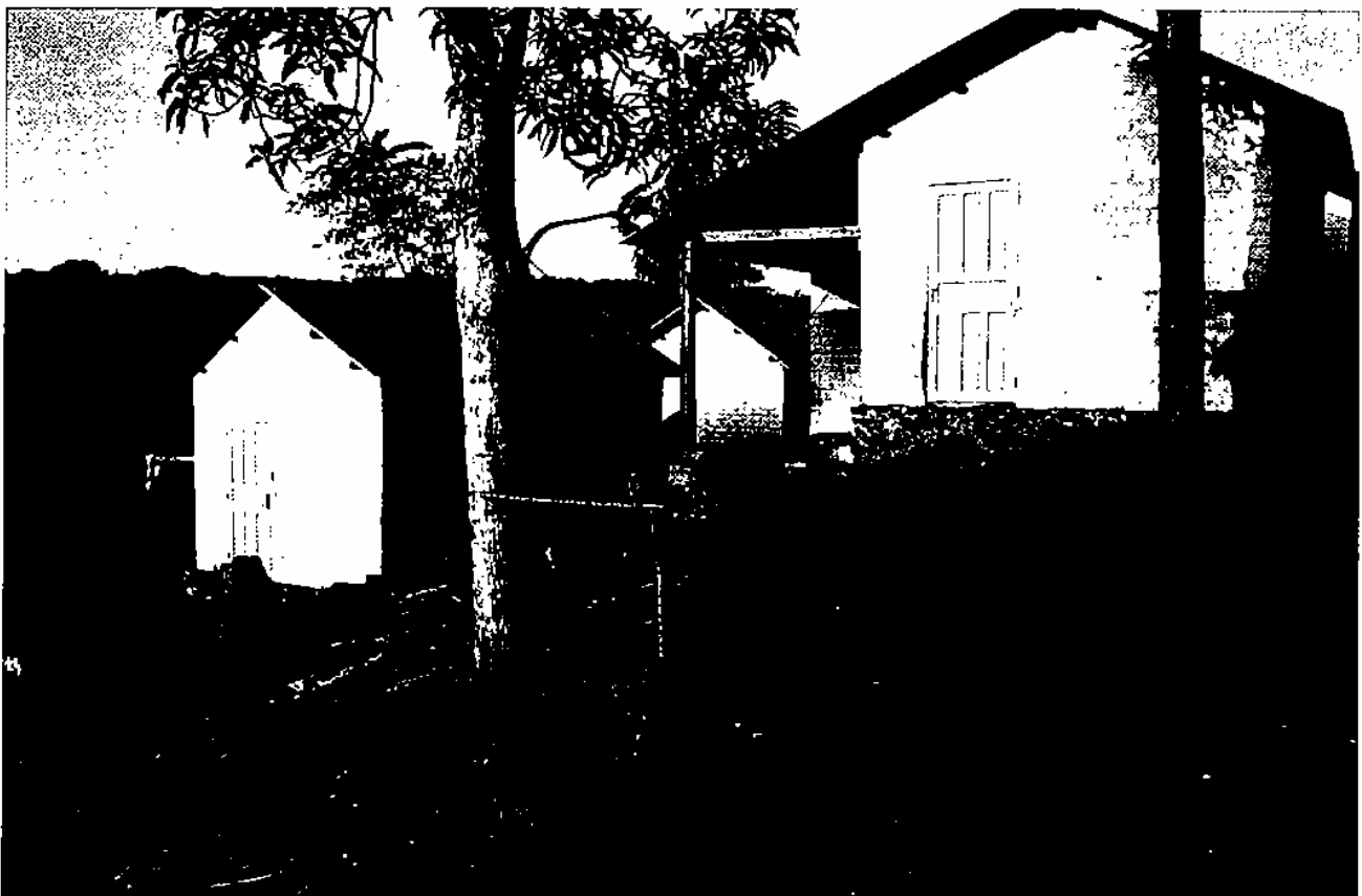
Fig. 189 : Cases d'habitat social "Aide en nature" en blocs de terre comprimée, implantées sur un terrain en pente.
