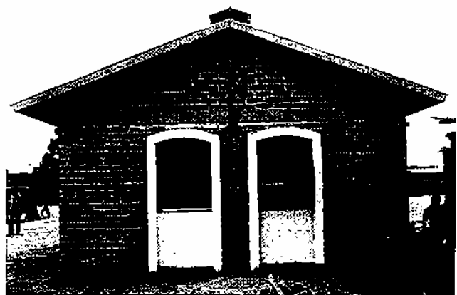
Fig. 133 : Toiture inclinée en tôles à Alotobo, Côte d'Ivoire.
