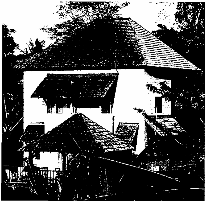
Fig. 20 : Mayotte : Villa de location, d'inspiration malgache. Réalisation SIM.
