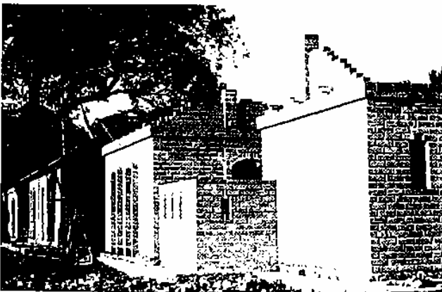
Fig. 210 : Vue de l'opération en chantier.
