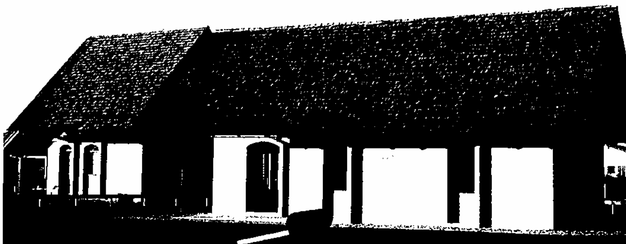
Fig. 256 : Vue de la façade du logement de type T4, de plain-pied.
