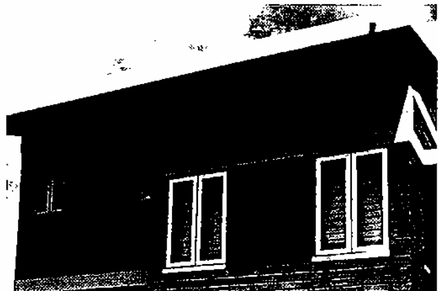
Fig.114 : Menuiseries au nu extérieur du mur, Inde.
