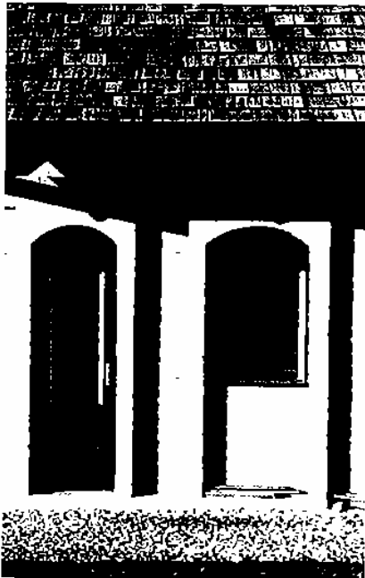
Fig. 274 : En rez-de-jardin, sous l'auvent du porche d'entrée. Proximité des deux tableaux saillants à arcs surbaissés de la porte d'entrée et d'une des fenêtres du séjour. Effet géométrique accusé par l'ombre portée sur le mur et projetée depuis l'auvent.
