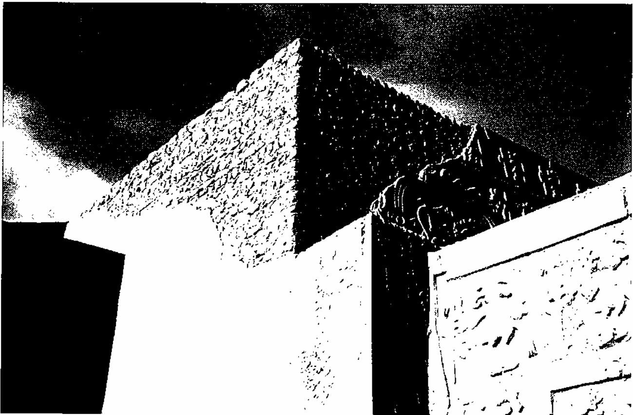
Fig. 8 : Site de Chan-Chan, Pérou. "Huaca del dragon". Construction en brique d'adobe.
