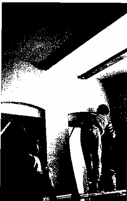
Fig. 252 : Finition au plâtre.
