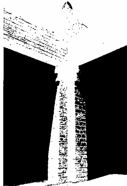
Fig. 60 : Poteau massif et complexe en "X".
