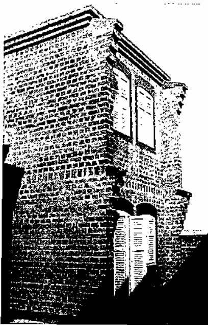
Fig. 244 : Vue de l'une des travées.
