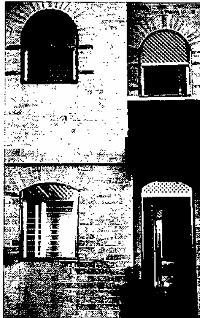
Fig. 275 : Vue détaillée des ouvertures au nu du mur, en rez-de-jardin et à l'étage. Effet esthétique donné par l'épaisseur affirmée de l'arc et par la légèreté du remplissage en menuiserie ajourée de bois ou de lames de verre.
