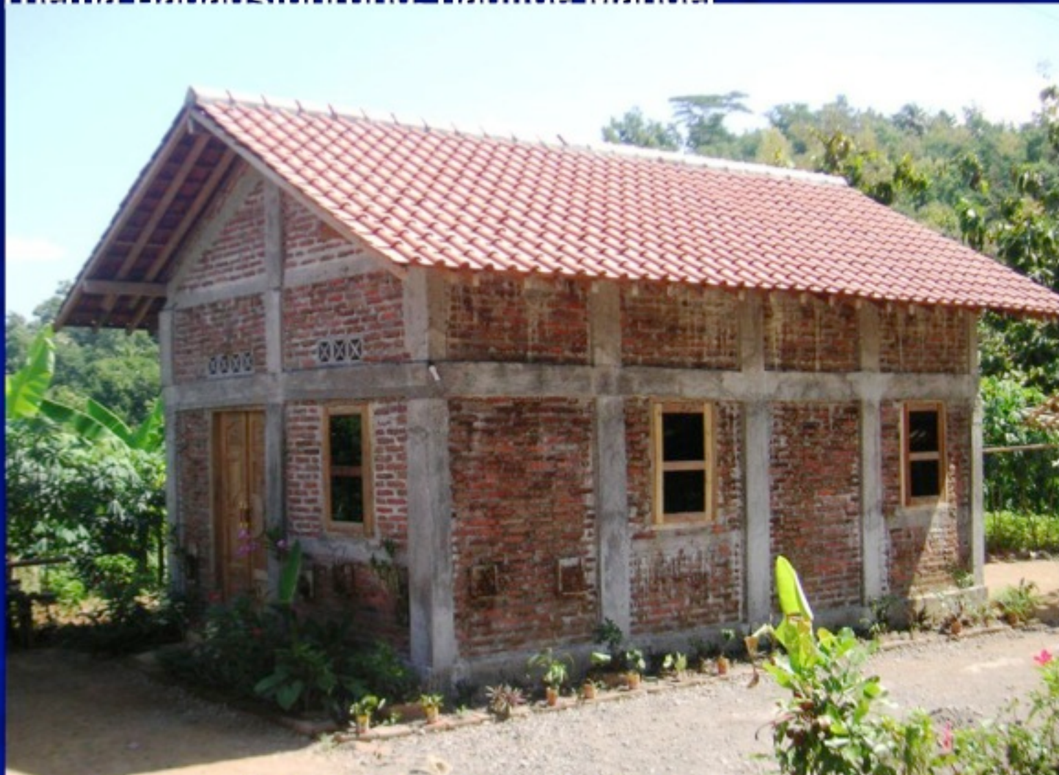
Zweckmässiger Betonriegel mit Ausmauerungen nach indonesischer Norm
