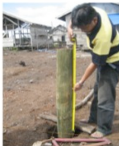
Gambar.15. Pengukuran ketinggian tiang
