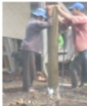
Gambar.13. Proses pemancangan tiang menggunakan Pompa air (water pressure)
