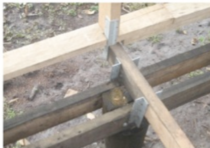
Gambar.45. Pemasangan balok lantai tengah
