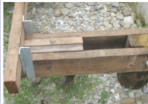
Gambar.24. Sambungan ujung bantalan utama
