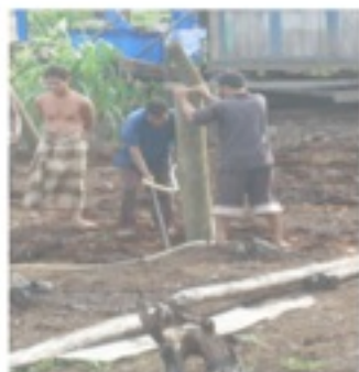
Gambar.13. Proses pemancangan tiang menggunakan Pompa air (water pressure)
