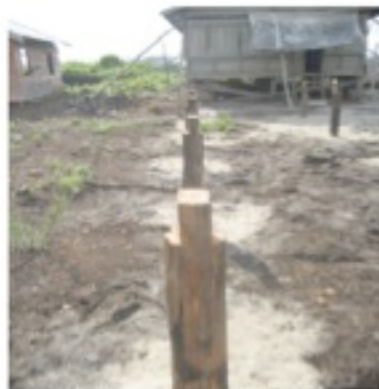
Gambar.22. Tiang yang sudah ditakik
