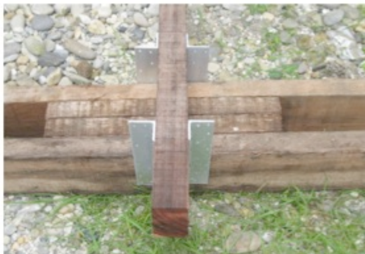
Gambar.44. Balok lantai tengah dan plat B
