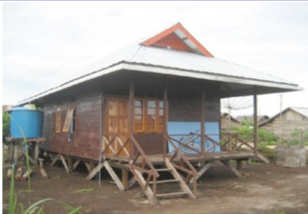
Gambar.152. Konstruksi Rumah yang sedah selesai
