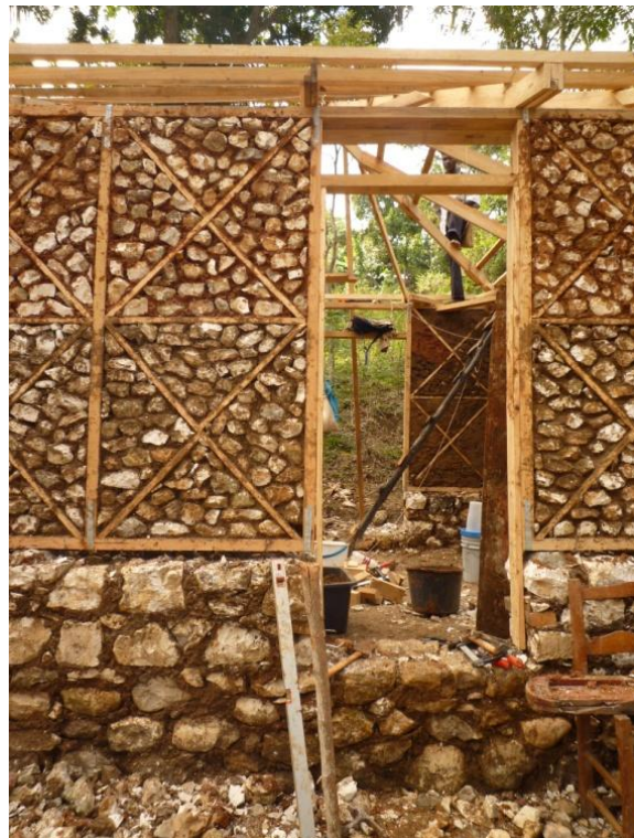
Fixation du cadre de porte au soubassement et aux poteaux.
