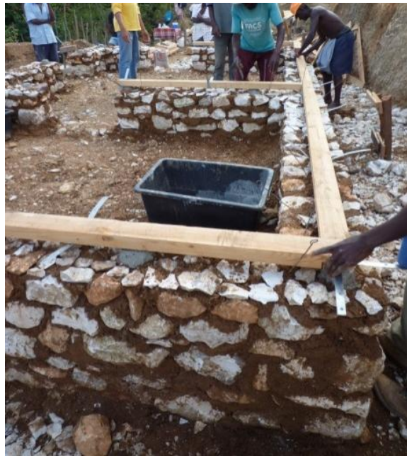
Liste basse et ligatures plates en attente des poteaux.
