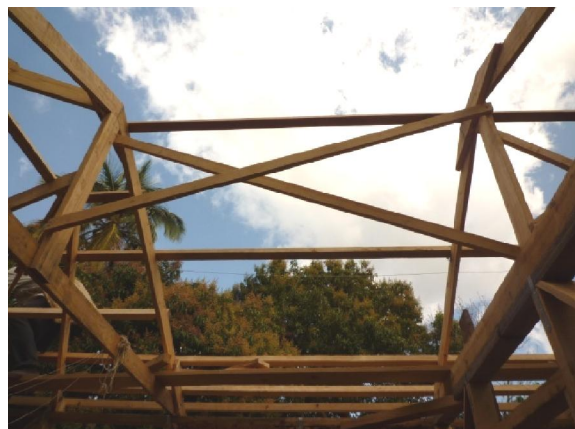
Contreventement des fermes dans la toiture.
