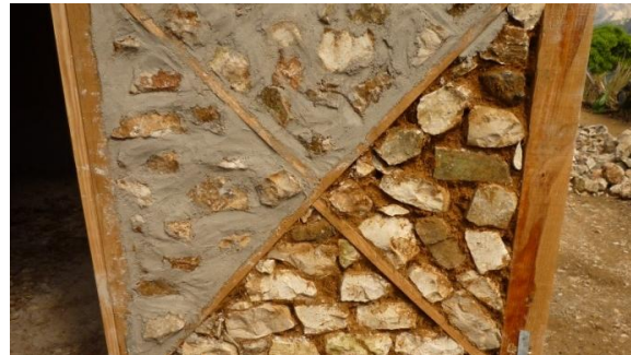
Avant (droite) et après (gauche) l'application du mortier bâtard.
