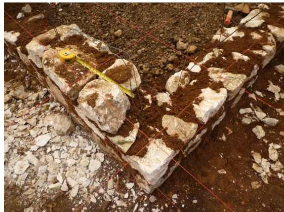
Fondation (droite) et début de soubassement (gauche).
