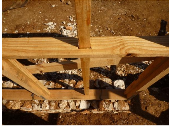
Vue des tringles et du raidisseur horizontal pour le panneau en clissage.
