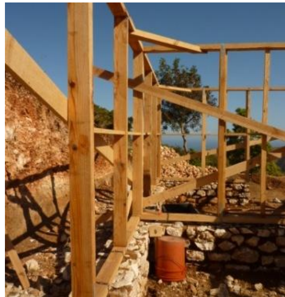
En haut : bras de contreventement dans le plan horizontal. Au centre : raidisseurs horizontaux.
