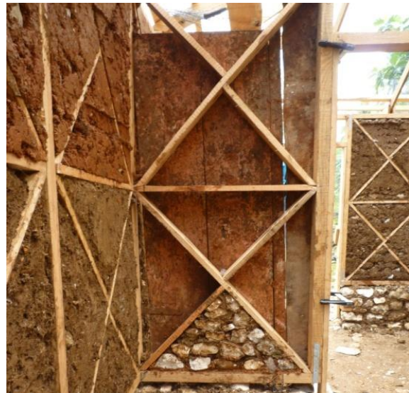
Construction du panneau contreventé en ti woch.
