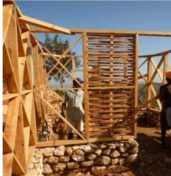
Gauche : panneaux contreventés : remplissage en ti woch : et croix de saint André. Droite : panneau non contreventé ( clissage ).
