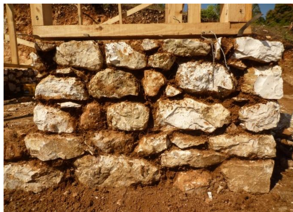
Joints du mortier de terre après le grattage.
