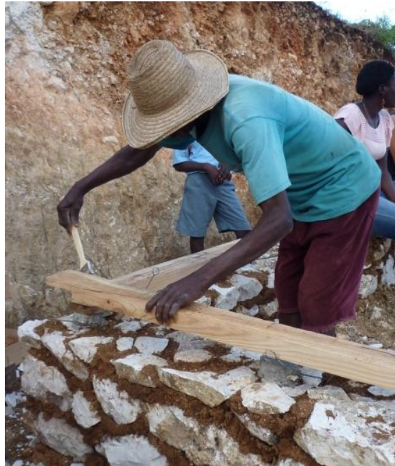
Application du Zincomat sur un joint mi-bois.
