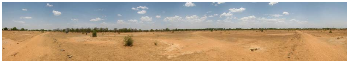
VUE PANORAMIQUE DU SITE AVANT TRAVAUX
