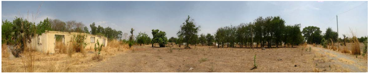
VUE PANORAMIQUE D'UNE PARTIE DU SITE AVANT TRAVAUX
