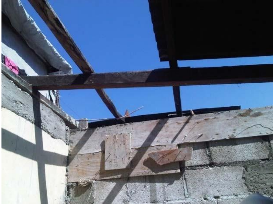
Figure E3. Exemple d'un nouveau chainage dans la partie supérieure d'un mur
